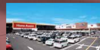
▲ペイドリーム清水 竣工・開業
